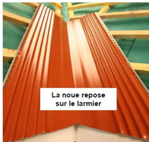
Figure 7 – Traitement du bas de pente
