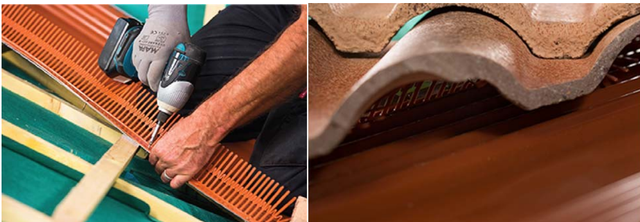
Figure 10 – Pose des tuiles à fort galbe sur peigne d'égout
